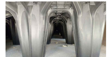
ENCOFRADO PERDIDO SOLERA VENTILADA
